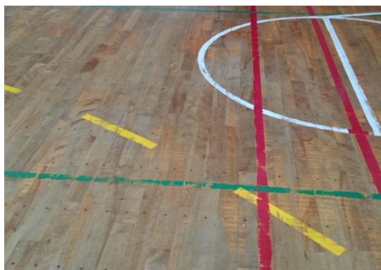
写真 2 ラインの欠け
