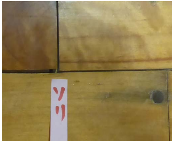
写真 7 目隙(長さ 590mm、幅 3.9mm)、 段差(0.5mm)
