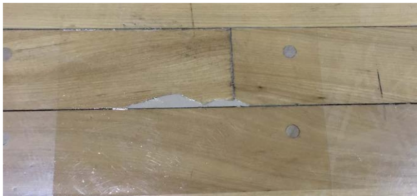
写真 5 パテによる補修例
