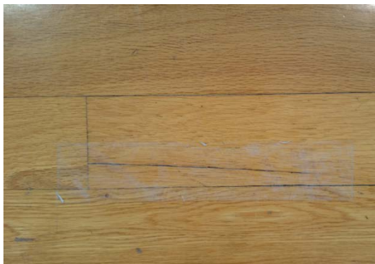
写真3 床板の割れを テープで補修
