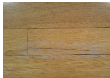
写真3 床板の割れをテープで補修
