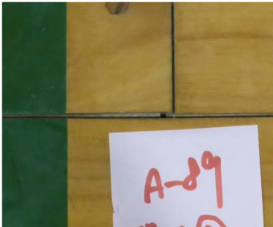
写真 6 目隙(長さ 590mm、幅 5.6mm)
